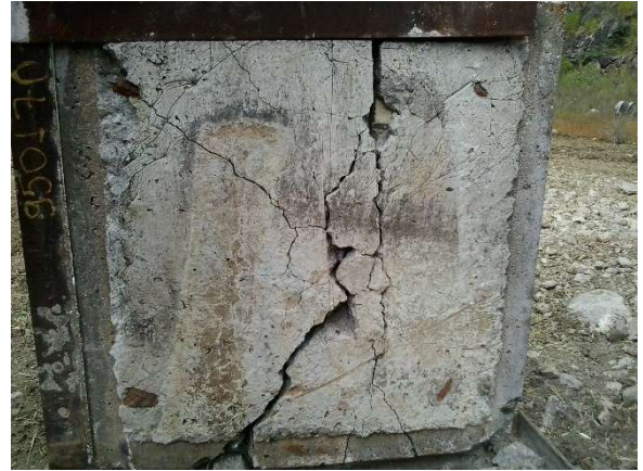
Fig. 5. Ruptura do concreto. Visão da face inferior da laje após a detonação a 1,5 m da laje.
